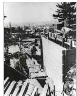
建設現場の様子
