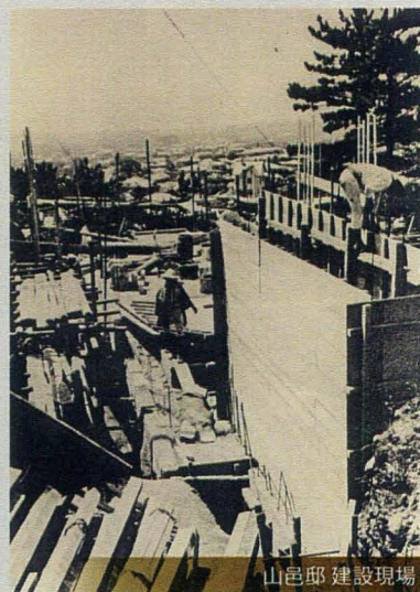
山邑邸 建設現場
