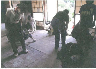
4. 床工事：畳を外すと荒板と呼ばれる下地が現れる。長年の間に乾燥して釘がゆるんでいる箇所をビス留めしているところだ。その後、断熱材としてスタイロフォームを敷き、その上から合板を張った。フローリングで仕上げるのは次回に持ち越しだ
