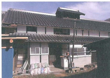
2. 古民家：築100年を越している。かつて茅葺きだった屋根は瓦葺きに改修され、入口付近にはトイレや風呂が増築されていた
